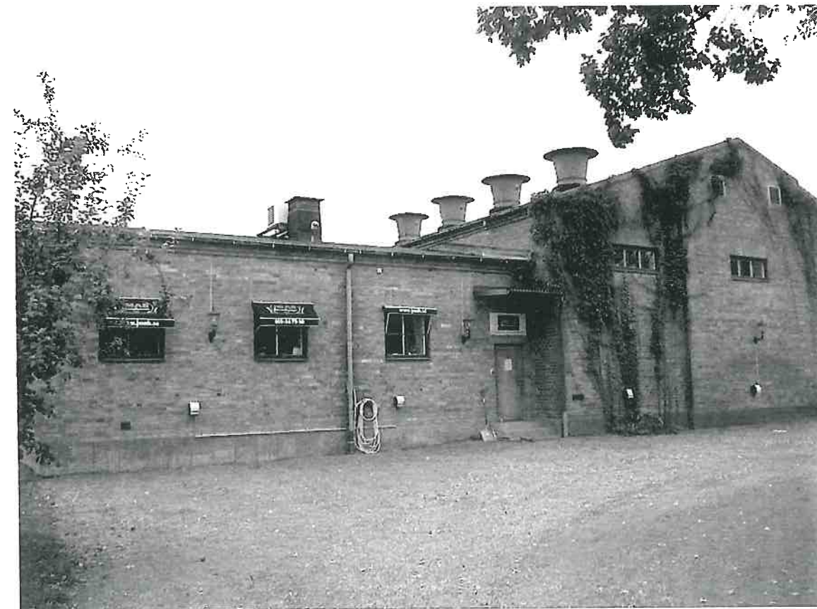
Stambanan mot Sala elektrifierades 1932. I samband med detta uppfördes en omformarstation i Husbyborg. Byggnaden är ansluten till banan med stickspår, transformatorerna rullades in i huset som är utrustat med ventilationsskorstenar i taknocken. Anläggningen inhyser numera ett elföretag. Foto JP Darphin.
