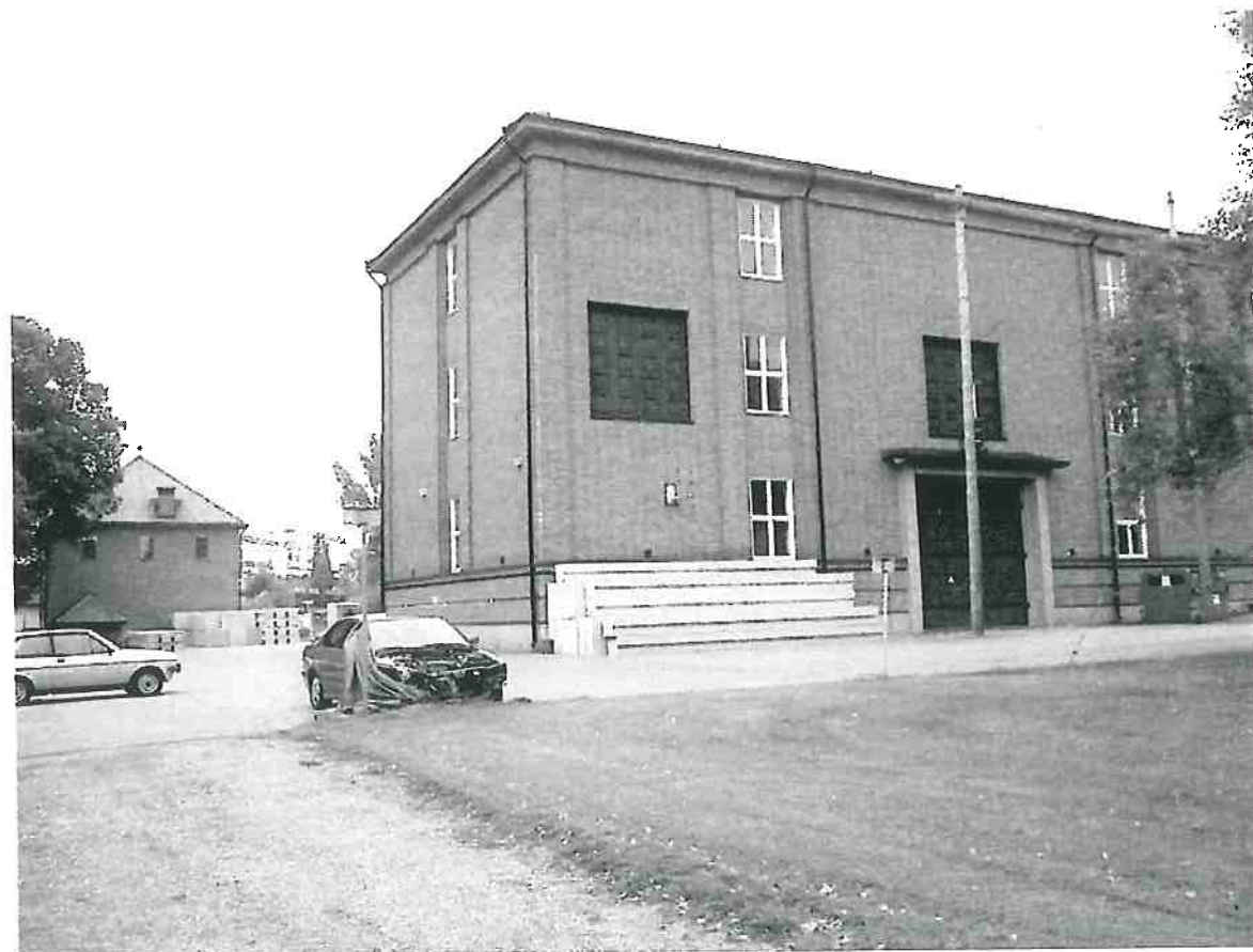
Institutet för högspänningsforskning grundades 1930 och anlades i Husbyborg i anslutning till Vattenfalls el-station. Anläggningen som ritades av S. Lindsjö invigdes 1934 och kompletterades därefter i flera etapper med tjänstebostäder samt 1956 med en byggnad för undervisning. Foto JP Darphin.
